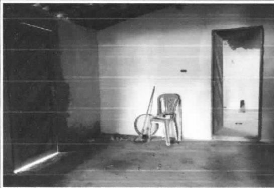
FOTO 07 - ACESSO PARA ÁREA DE LAZER - TÉRREO
